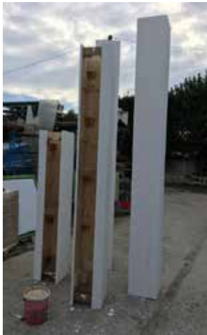
Stand Innovambienper Fiera Ecomondo. Falegnameria, costruzione stand con tavole di abete, levigate e pitturate. 2017
